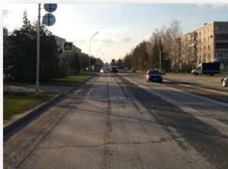
Ул. Ленина г. Заречный до и после ремонта
